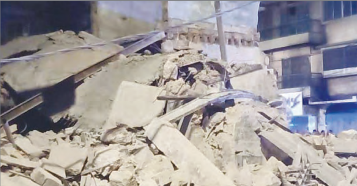
المبنى المنهار يُعيد إلى الواجهة أزمة عشرات المباني المتهاكّة في طرابلس
