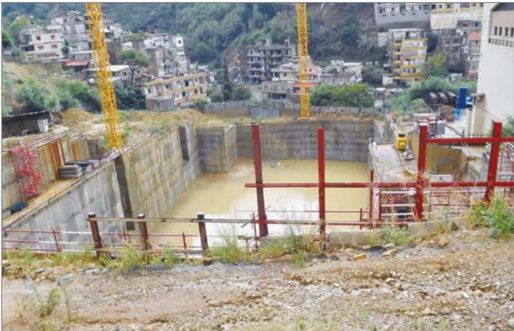
حفرة بعمق 30 متراً تُحضّر للبناء (تصوير رمزي الحاج)
