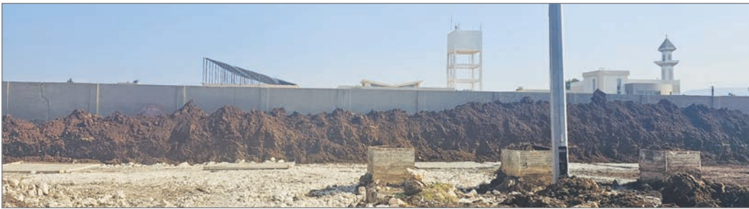
أعمال البناء الجديدة في السوق
