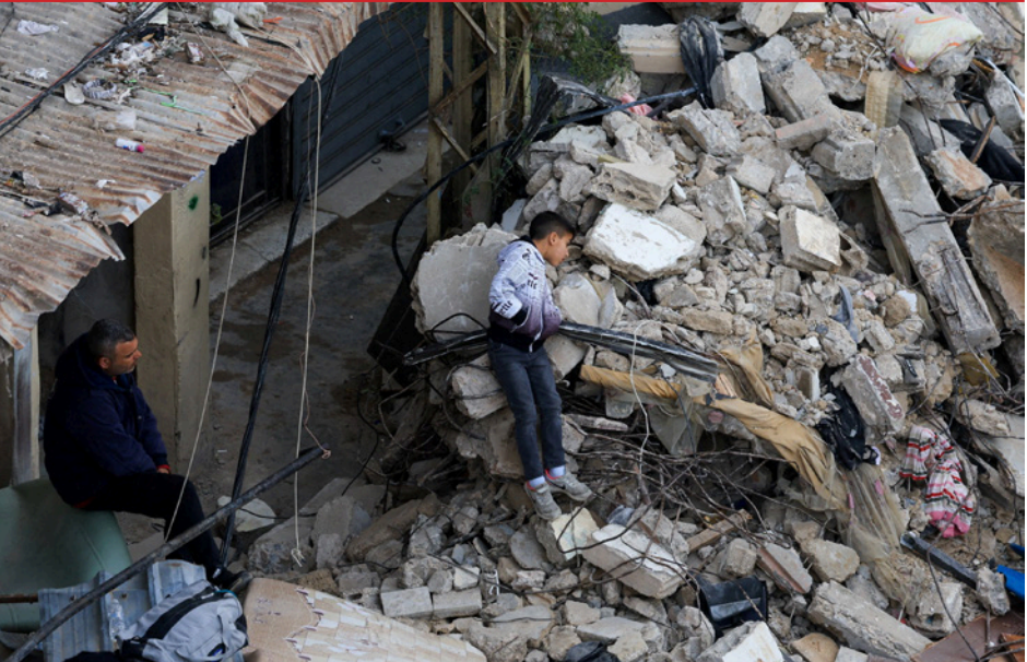
قرابة 600 مبنى آيل للسقوط
